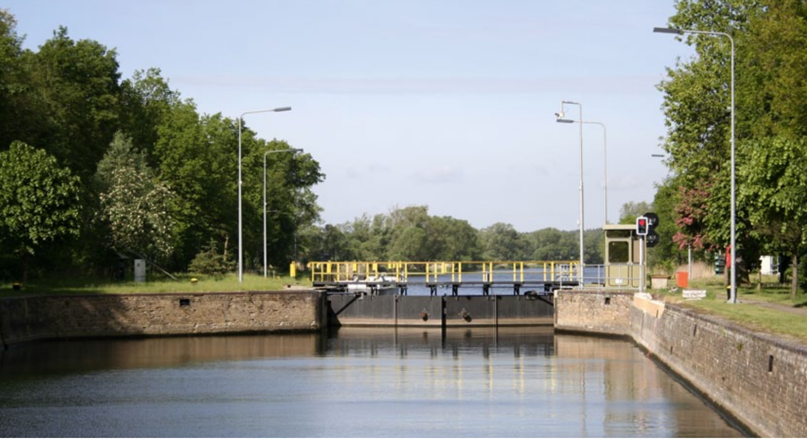
Schleusen überwinden Staustufen
